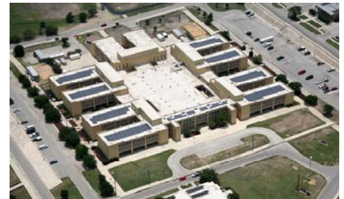
Meridian 180 kW Project : Fort Sam Houston San Antonio, TX
